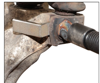
Stützwinkel in die Schlitz einsetzen...
